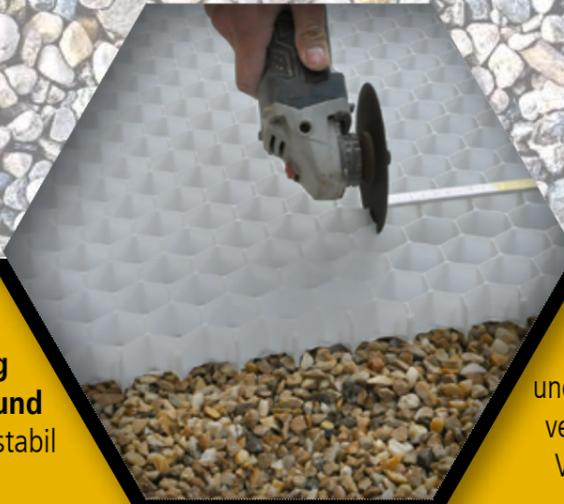
Die **Kiesplatten** werden auf Kreuzfuge gelegt und an allen vier Seiten ineinander verklinkt. Durch das Gewicht der Verfüllung stabilisieren sich die Platten von selbst.
