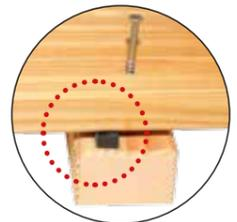
Das einseitig klebende Distanzband wird auf die Unterkonstruktion geklebt. Im Anschluss werden die Dielen von oben verschraubt.
