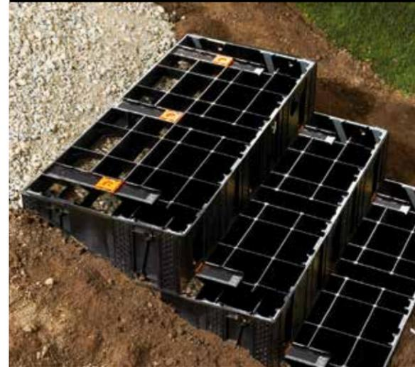
Schaufel, Wasserwaage, Schraubenzieher und Modulesca ist alles, was für die Gartenteppe gebraucht wird.
